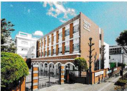
令和元年には特別教室棟が、明るい校舎に生まれ変わりました。
